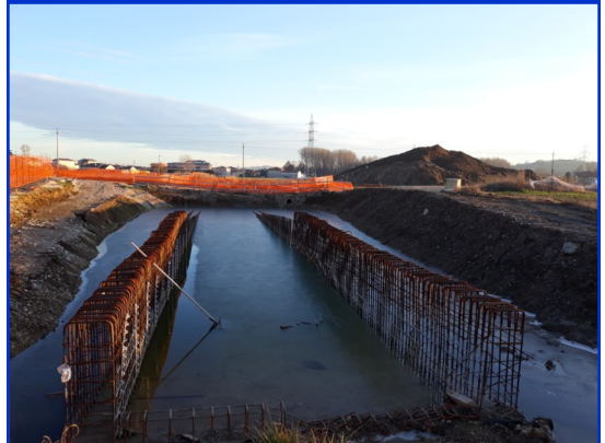
Nella foto in alto il sotto passo Strada Pian di Maddalene ultimato ma non ancora aperto; nella foto sotto, lo stato attuale dei lavori al sottopasso della pista ciclabile al Moracchino.
